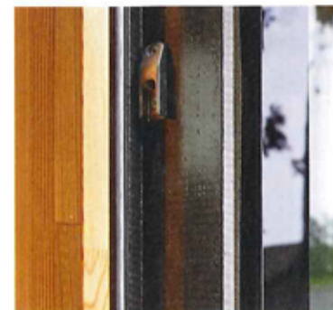
Außenansicht mit geöffnetem Drehflügel: Pfosten mit aufgesetztem GFK-Profil
