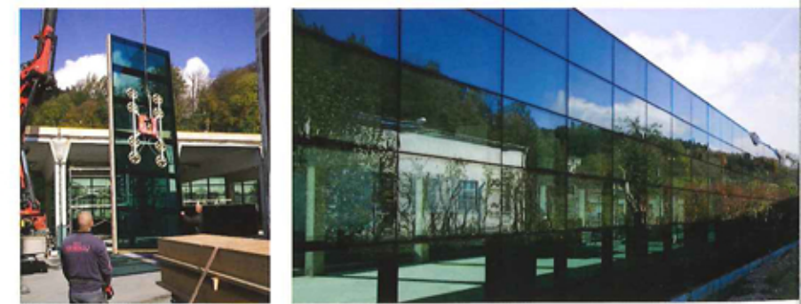
Montage und Realisierung von Ganzglasfassaden.
